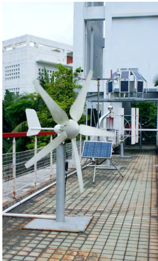
风光互补扬水系统运行测试及数据采集
