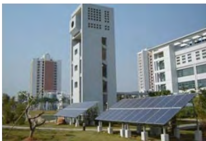
光伏水泵运行测试及数据采集
