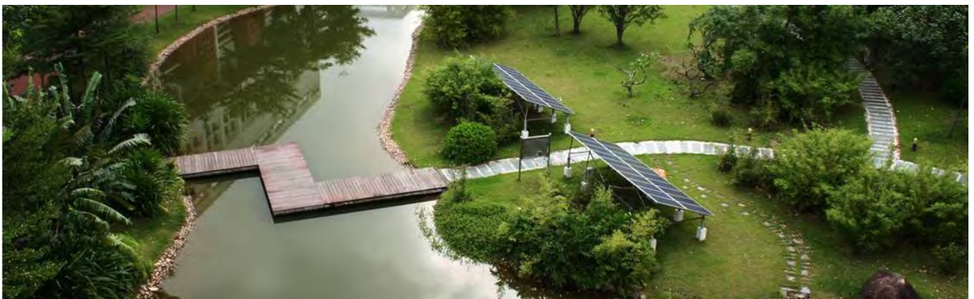
光伏扬水系统运行测试及数据采集
