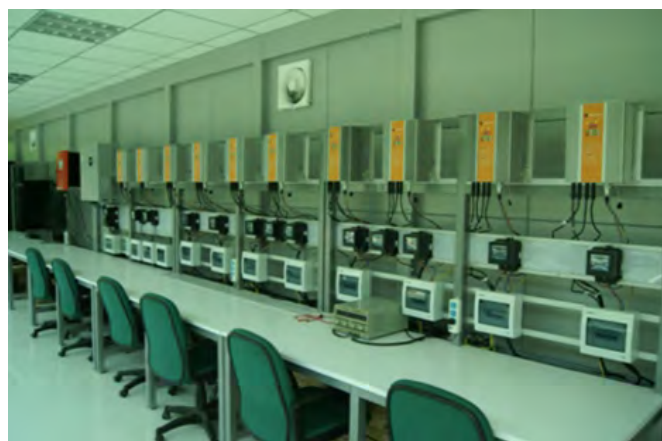
光伏、市电、风力、储能、联网运行管控
