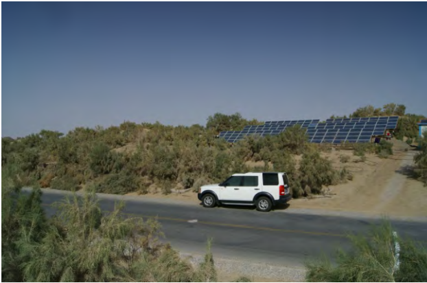
全球第一套沙漠高速公路防护林光伏灌溉系统 (2001年建于塔克拉玛干沙漠)
